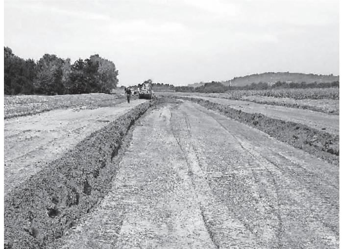
Nach witterungsbedingtem Stillstand der Baustelle gehen die Arbeiten am 6. Juli 2015 weiter. Erhöhte Grundwasserstände behinderten einen ordnungsgemäßen Bodenaustausch und führten zu einer Zwangspause der Arbeiten. Nun werden die bindigen Bodenschichten herausgenommen und durch Kiessandgemische ersetzt. Die Arbeiten werden voraussichtlich bis Ende August 2015 abgeschlossen sein.
